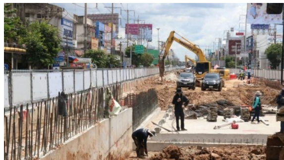
รูปที่ 8-7 ขั้นตอนที่ 4 การก่อสร้างพื้นทางลอด ในพื้นที่ก่อสร้าง ระยะที่ 2
