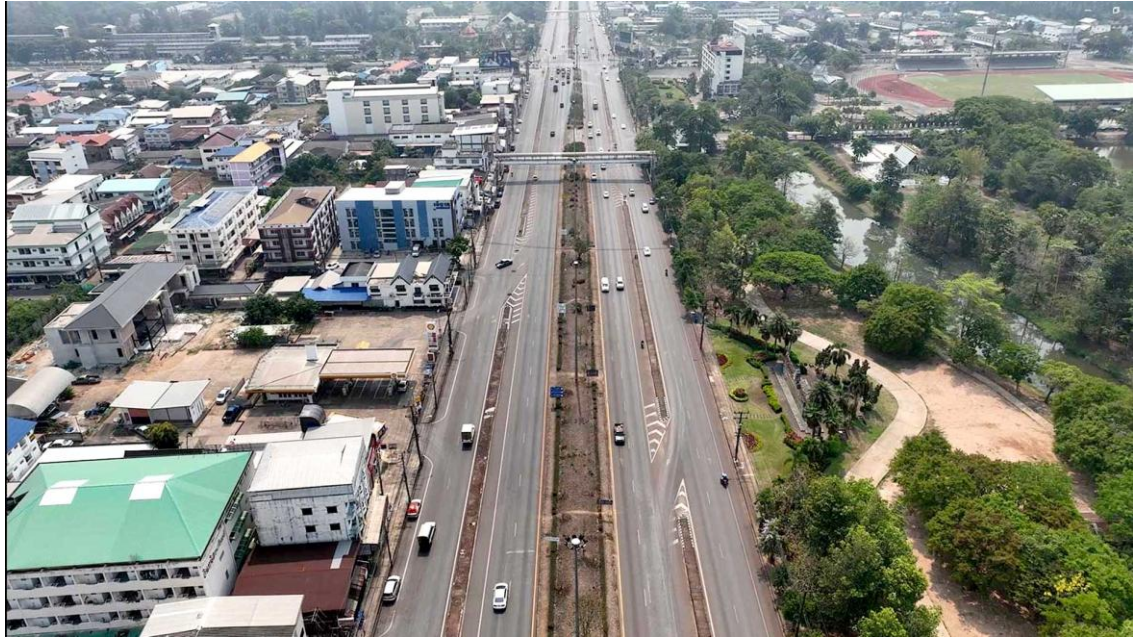
สภาพบริเวณทางแยกบ้านธาตุนาเวงปัจจุบัน (ก่อนก่อสร้างทางลอด)
