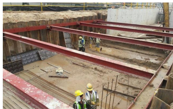
รูปที่ 8-5 ขั้นตอนที่ 2 การติดตั้งโครงสร้างค้ำยันชั่วคราว (Temporary Strut) และการก่อสร้างเสาเข็มเจาะ ในพื้นที่ก่อสร้าง ระยะที่ 2
