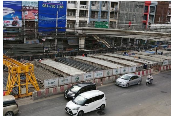
รูปที่ 8-6 ขั้นตอนที่ 3 การก่อสร้างโครงสร้างหลังคาทางลอด ในพื้นที่ก่อสร้าง ระยะที่ 2
