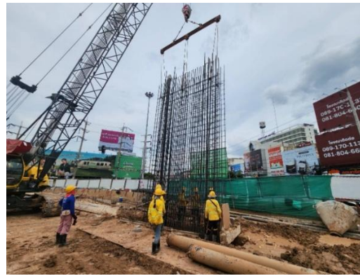
รูปที่ 8-4 ขั้นตอนที่ 1 การก่อสร้างกำแพงทางลอด ในพื้นที่ก่อสร้าง ระยะที่ 2
